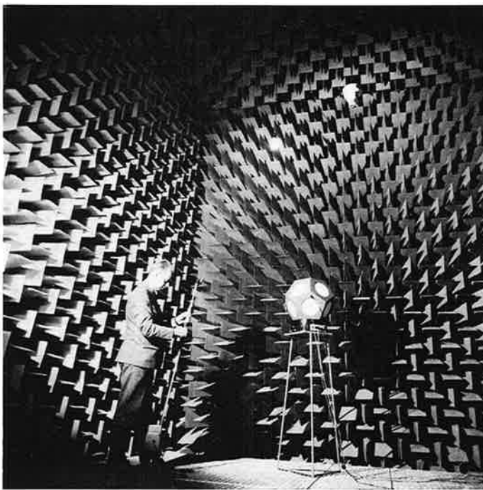
In onze samenleving is de urgentie van geluidsproblemen in de woningbouw sterk toegenomen. Voor onderzoek naar de beste geluidsisolatie wordt bij TNO in Delft gebruik gemaakt van een reflectie-vrije kamer, een ruimte waarin geen enkel geluid wordt teruggekaatst.
