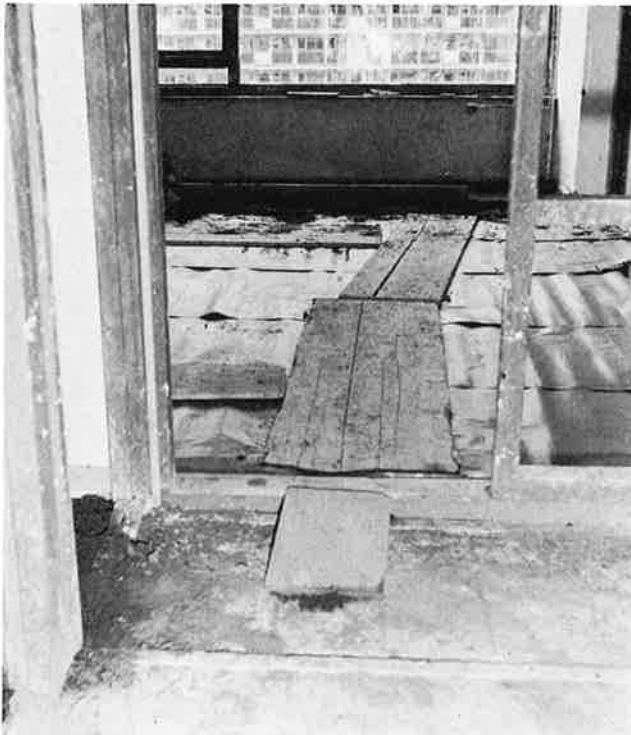
Kruidelen gebruikt, de veerkrachtige laag wordt niet beschadigd. De veerkrachtige laag in de gang is nog niet uitgelegd.
