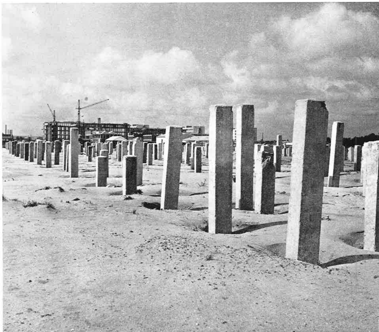
In aanbouw zijnd T.N.O.-complex Zuidpolder te Delft voor een aantal instituten van de Nijverheidsorganisatie en het Instituut voor Gezondheidstechniek van de Gezondheidsorganisatie T.N.O. Situatie einde 1958.
