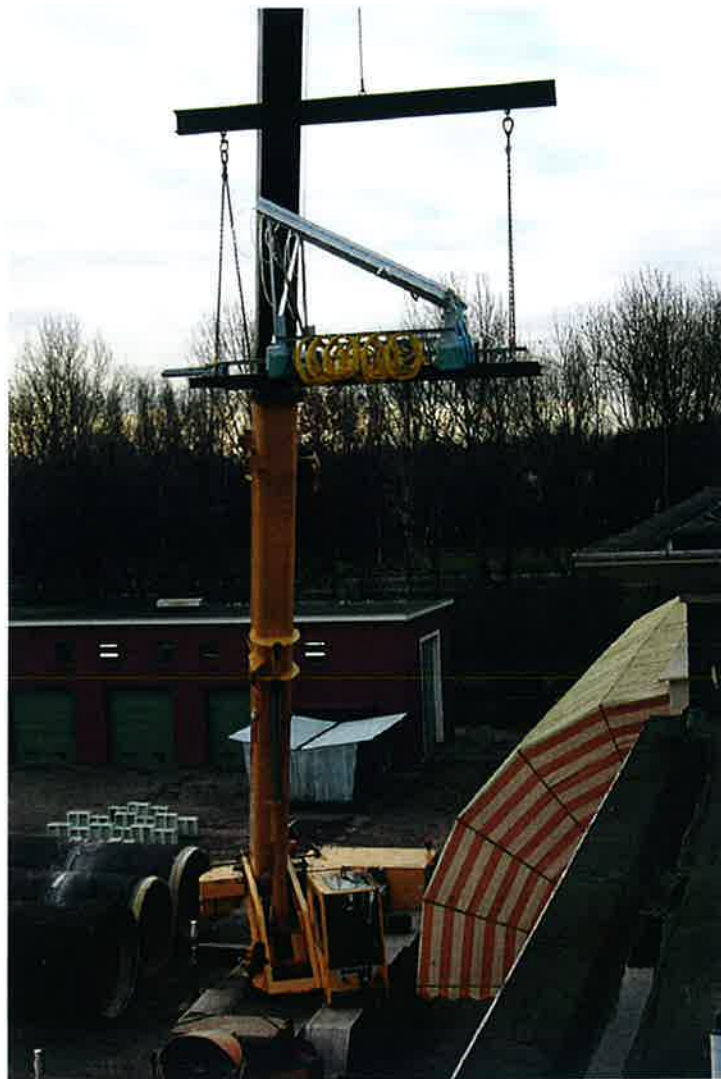
Foto C.10: Het plaatsen van het meetsysteem op het dak.
