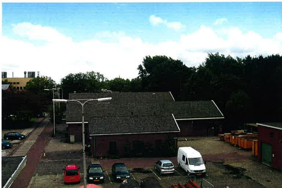
Foto C.8: Blik op het oosten; foto gemaakt voor start meetcampagne (vergelijk foto B.4)
