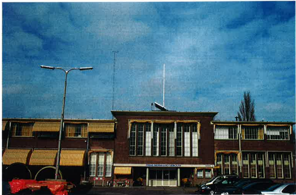
Foto C.6: Aanzicht van het gebouw vanuit oosten, met opstelplaats collector en mast.
