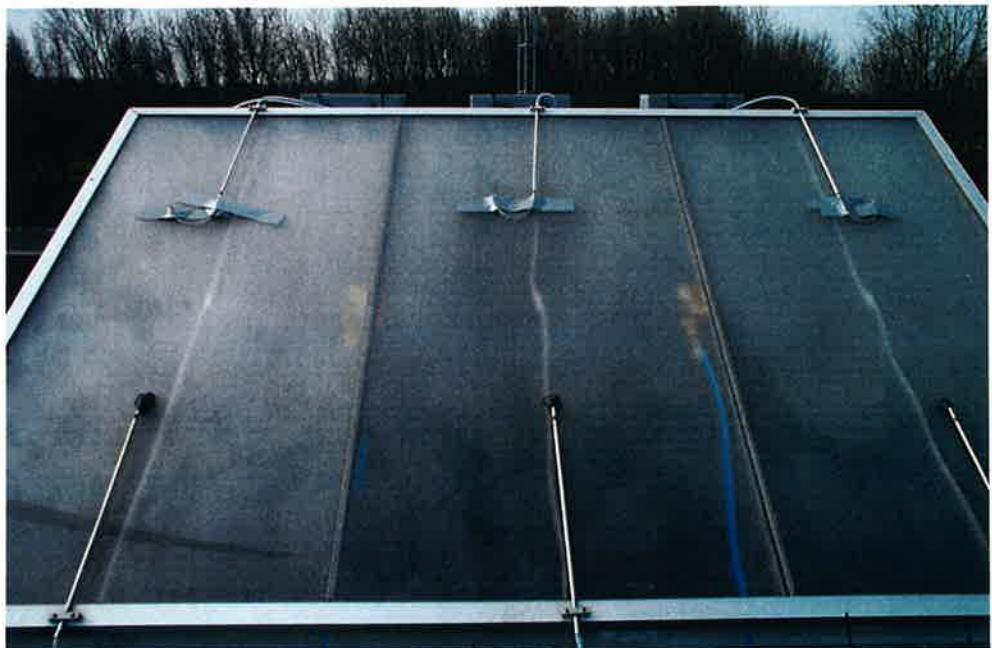
Foto C.12: Aanzicht collector met drukmeetpunten op glasplaat.
