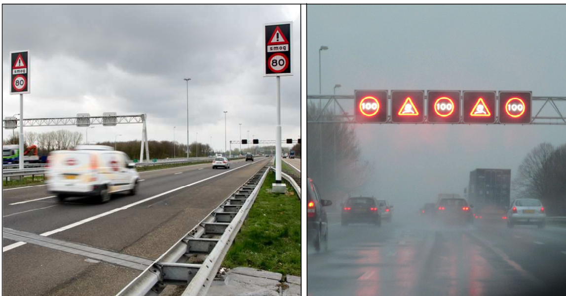
Figuur 1: (links) Rotatiepanelen op de A58 geven een verlaagde snelheidslimiet aan vanwege luchtkwaliteitsproblemen (rechts) Borden op de portalen over de weg op de A12 geven een snelheidslimiet van 100 km/u vanwege hevige regenval aan
