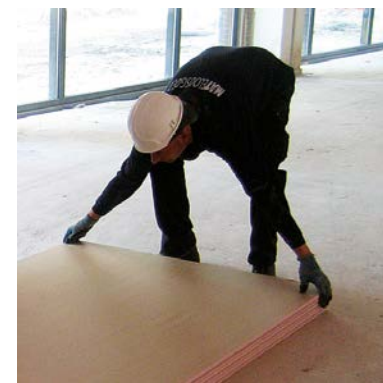
Platen op de grond neerleggen en oppakken
