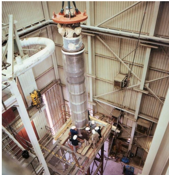
Foto 37 Inbouwen van de tussenwarmte-wisselaar in het 50 MW circuit
