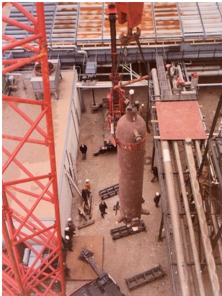
Foto 36 Inhijsen van de spiraal-gewonden verdamper in het 50 MW circuit
