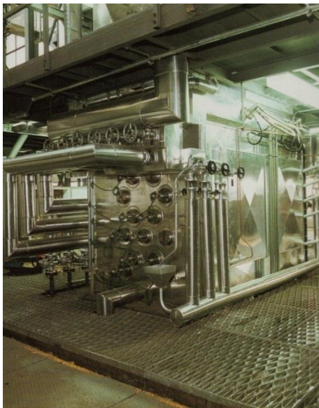
Foto 38 De 4 MW fluid bed oven in de hal van de afdeling Kernreactortechnologie
