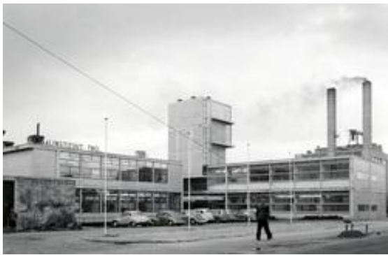
Foto 1 Het "nieuwe" MI-gebouw in Delft, 1958
