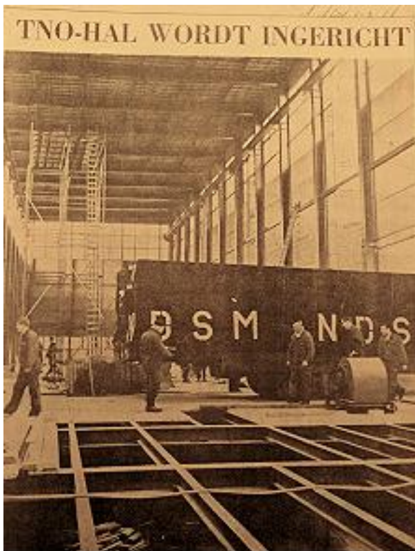
Foto 72 Intakelen natriuminstallatie uit vrachtwagen van NDSM (1965?)
