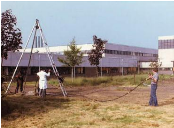
Foto 66 Het inbrengen van pijpen voor bodemwarmtewisselaars op het TNO-complex met vlnr: Hans van der Brugh, externe boorder, Arend Koppenol
