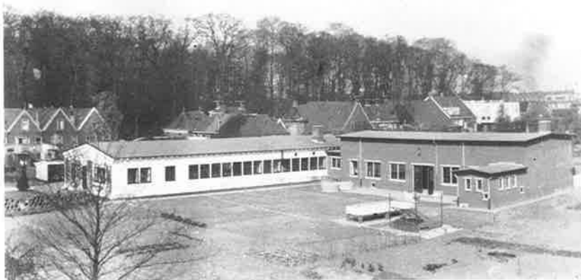
De situatie in 1952. Rechts op de foto de nieuwe aanbouw van 1951.
