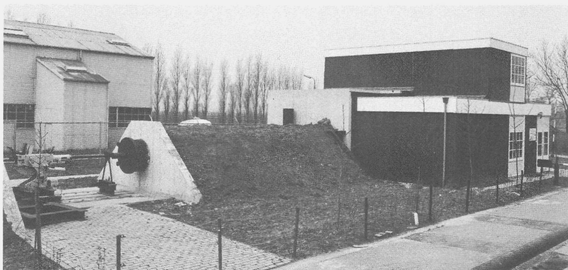
Bunker met schietunnel voor eindballistisch onderzoek. Vuurmond links op foto.
