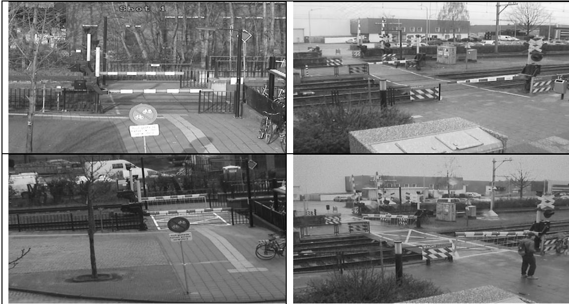
Figuur 1: Overpad bij Oisterwijk bij de nulmeting (linksboven) en effectmeting met hangwerk onder de bomen, aangepaste hekwerken en afgekruid kruisingsvlak (linksonder) en overpad bij Deurne bij de nulmeting (rechtsboven) en effectmeting (rechtsonder).
