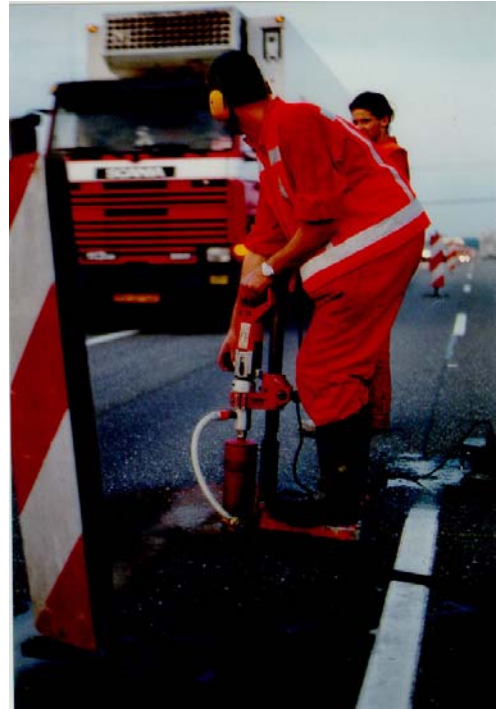
Afbeelding 3.3: De locatie/positie van de wegwerker is een belangrijke ongevaloorzaak
