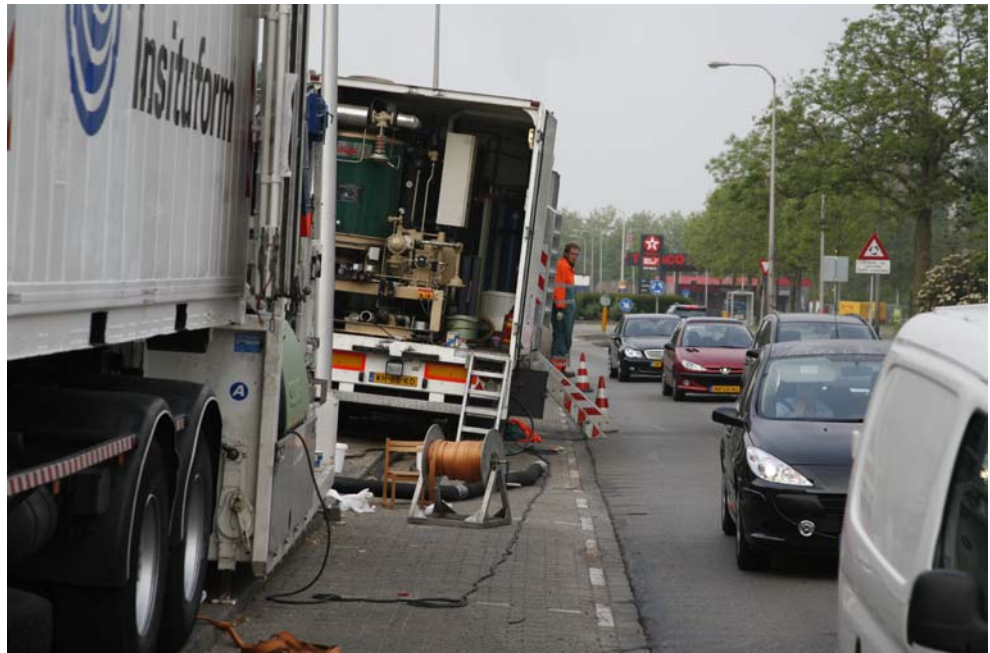
Afbeelding 3.1: Ruimte/scheiding tussen werkgebied en voertuigroutes is een in de literatuur vaak genoemde oorzaak voor onveiligheid
