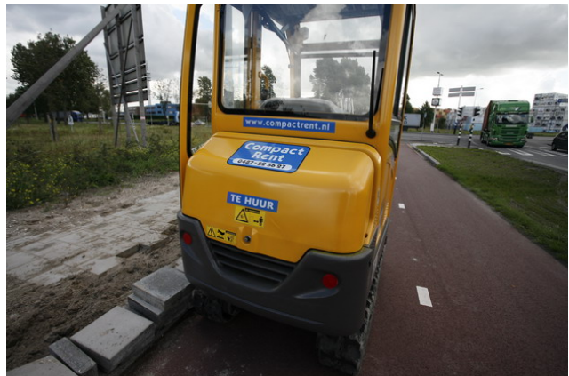
Afbeelding 1.1: Werksituatie op een fietspad
