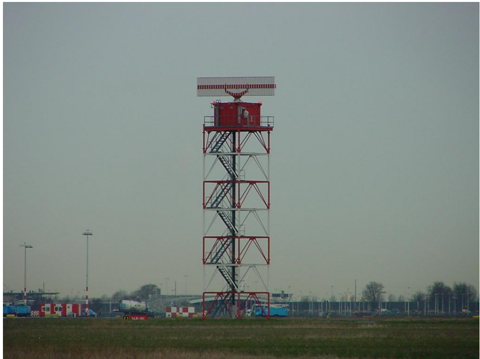
Figuur 13 De TAR 1 secundaire radar gelegen tussen de taxibanen van Schiphol.
