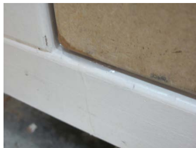
Figuur 38 Waterlekkage in de hoek van de deur.
