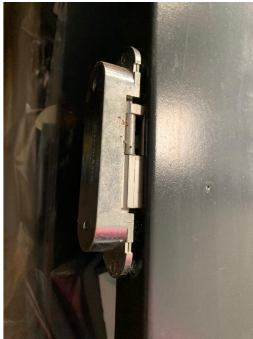
Figuur 46 Verscholen scharnieren.
