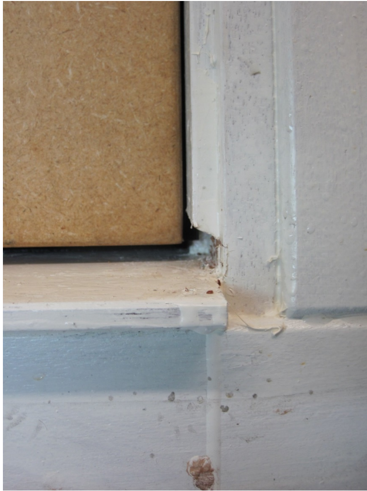
Figuur 63 Onderdorpel van voorzijde, lekkage is zichtbaar.
