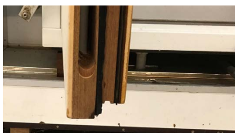
Figuur 31 Detail onderzijde deur met uitsparing accupakket.
