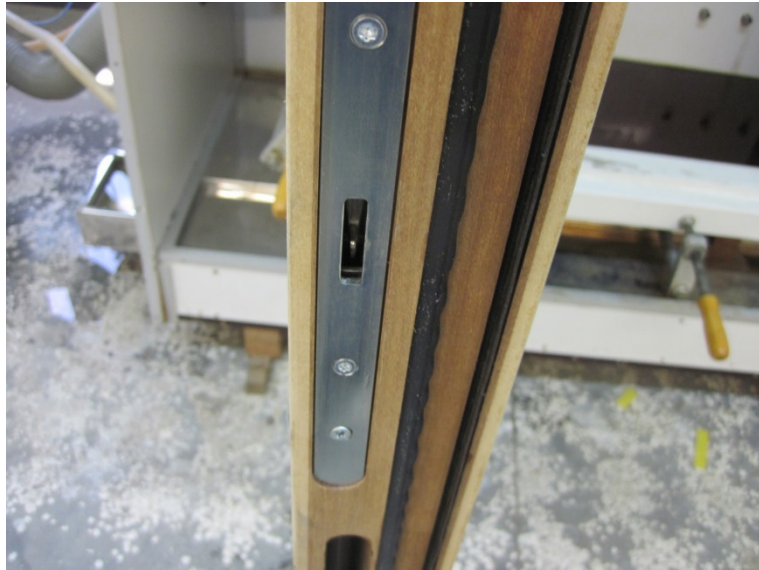
Figuur 61 Detail vergrendeling deur met dubbele rubberafdichting voor wind- en waterdichtheid.
