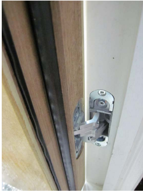
Figuur 28 Geïntegreerd deurscharnier (Roto).
