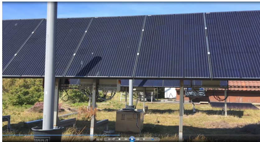
Figuur 2.19. Voorbeeld van de schaduw van de paal op de zonnepanelen op een onbewolkte dag (22 augustus 2019)
