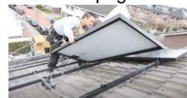
2. Plaatsen panelen op profielen
