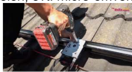
3. Plaatsen optimizers/micro invertors
