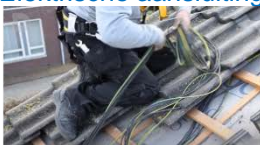
1. Kabels trekken onder pannen
