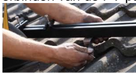
2. Bevestigen kabels aan beugels
