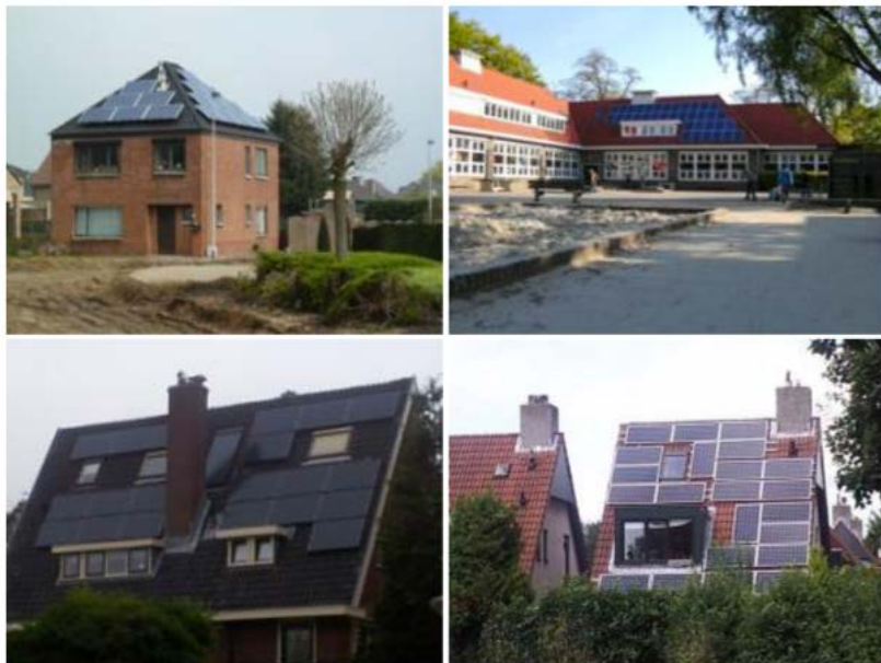
Figuur 3: Voorbeelden van inpassing van zonnepanelen op een bestaand schuin dak, waarbij de invloed van diverse belemmeringen in het dak zichtbaar wordt (foto's Flip ten Cate, Thuis Kurstjens). 4
