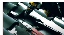
4. Bevestigen valbeveiliging (anker)
