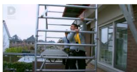
2. Plaatsen steiger waar mogelijk
