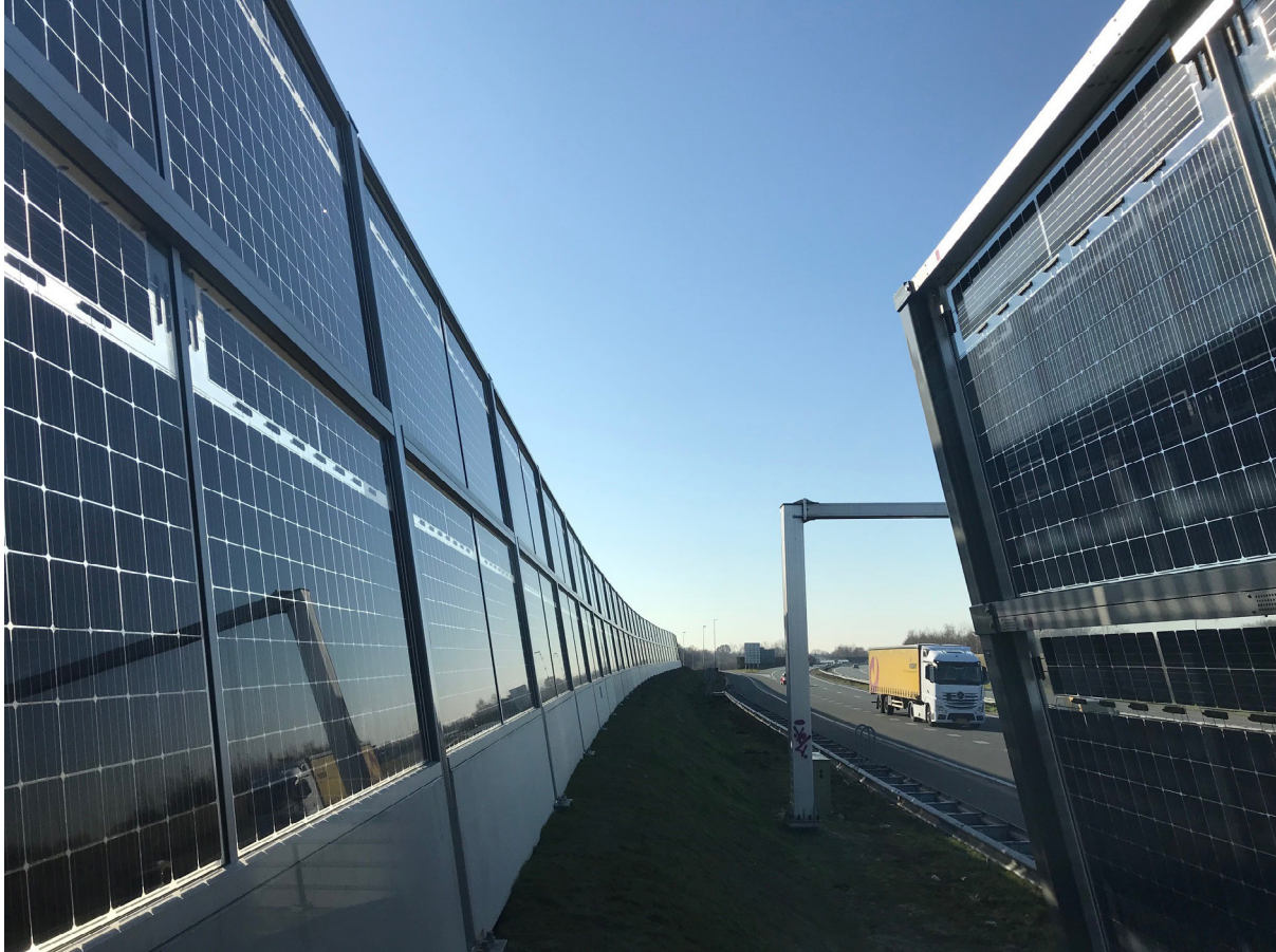
TWEEZIJDIG WERKENDE ZONNECELLEN IN EEN GELUIDSSCHERM (SOLAR HIGHWAYS) LANGS DE A50 BIJ UDEN.
