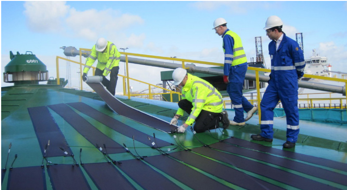
MONTAGE VAN ZONNEFOLIES (FOTO: HYET SOLAR/VOPAK)
