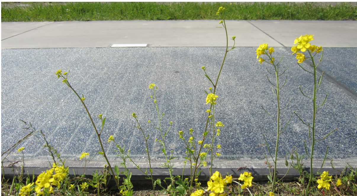
ZONNECELLEN IN HET WEGDEK (SOLAROAD).
