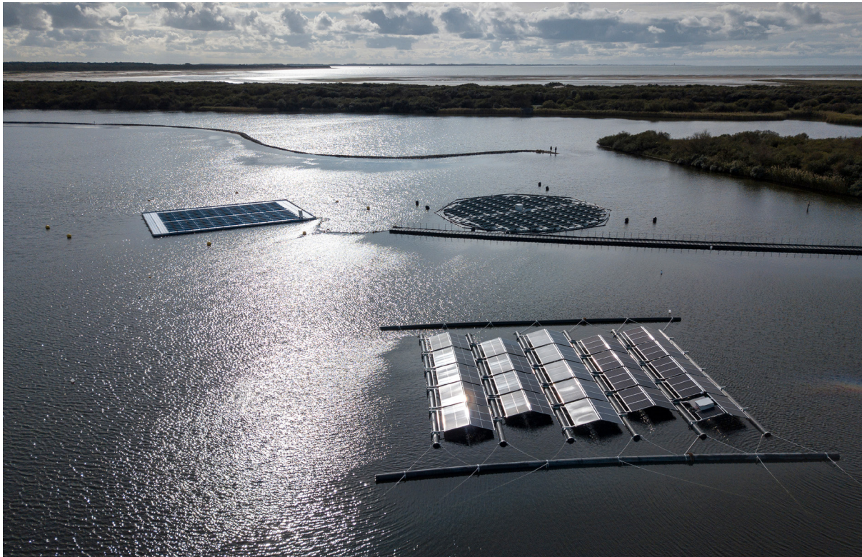
DRIJVENDE ZONNE-ENERGIESYSTEMEN OP DE TESTLOCATIE OOSTVOORNSE MEER.
