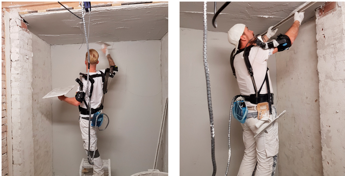
Figuur 6: Stukadoors aan het werk met een armondersteunend exoskelet (Skelex) tijdens het experiment door TNO en Knauf (de Vries e.a., 2020a)
