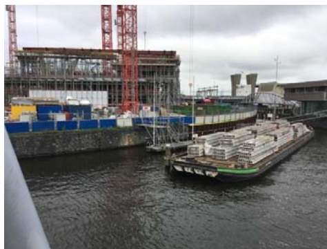
Figuur 7: Transport kanaalplaatvloeren naar ODE (bron: Sleepdienst en Dekschuitenverhuurderij Blom B.V.)
