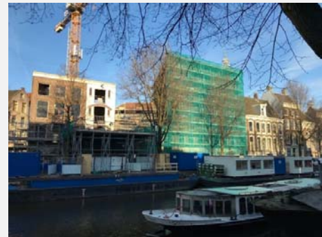
Figuur 15 Bouwproject Geldersekade
