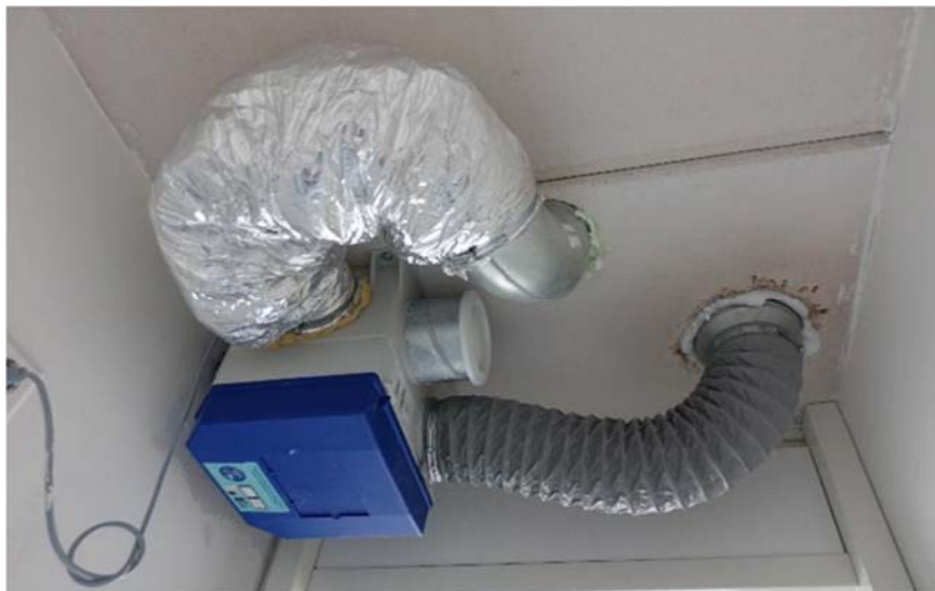
figuur 56: Voorbeeld van onjuist gebruik van de geluiddemper, met grote gevolgen voor het geluid, de drukval (en dus het elektrisch vermogen) en het debiet.
