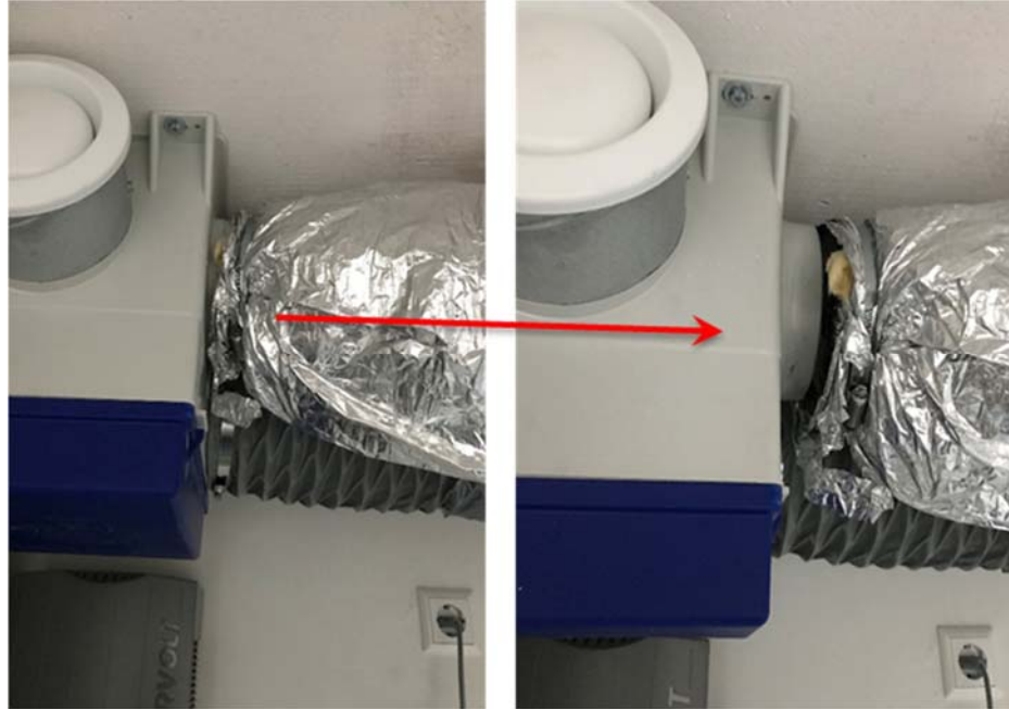
figuur 54: klem van demper los en lek, maar volgens opleverrapport debieten in orde.
