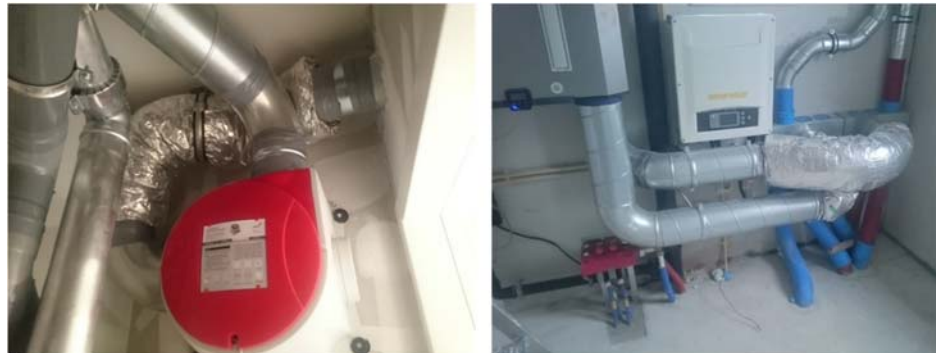
figuur 55: Voorbeelden van onjuist gebruik van de geluiddemper, met grote gevolgen voor het geluid, de drukval (en dus elektrisch vermogen) en het debiet.
