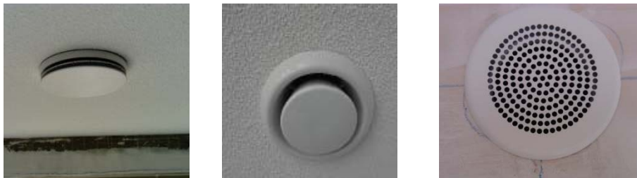
figuur 37: Respectievelijk Ventieltipe A (toevoerventiel), B (afvoerventiel) en C (toevoerventiel).
