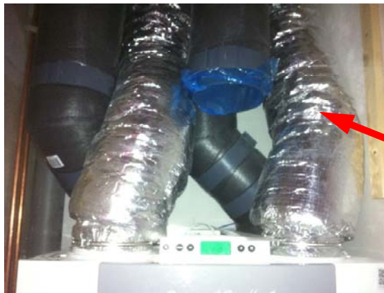
figuur 59: Losgekoppeld en afgeplakt buitenluchtaanzuigkanaal.
