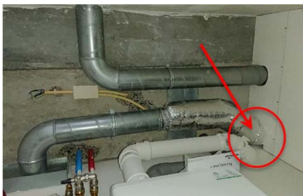
figuur 58: Voorbeeld van het onjuist gebruik van een geluiddemper in combinatie met het blokkeren van de doortocht van de demper na het monteren van een houten afdekplaat.
