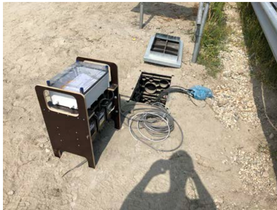
Figuur 18: Een van de putkasten en rek met optimizers klaar voor plaatsing
