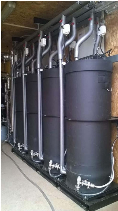
Figuur 4.2: Vier modules waarin warmte kan worden opgeslagen door middel van een thermochemische reactie.
