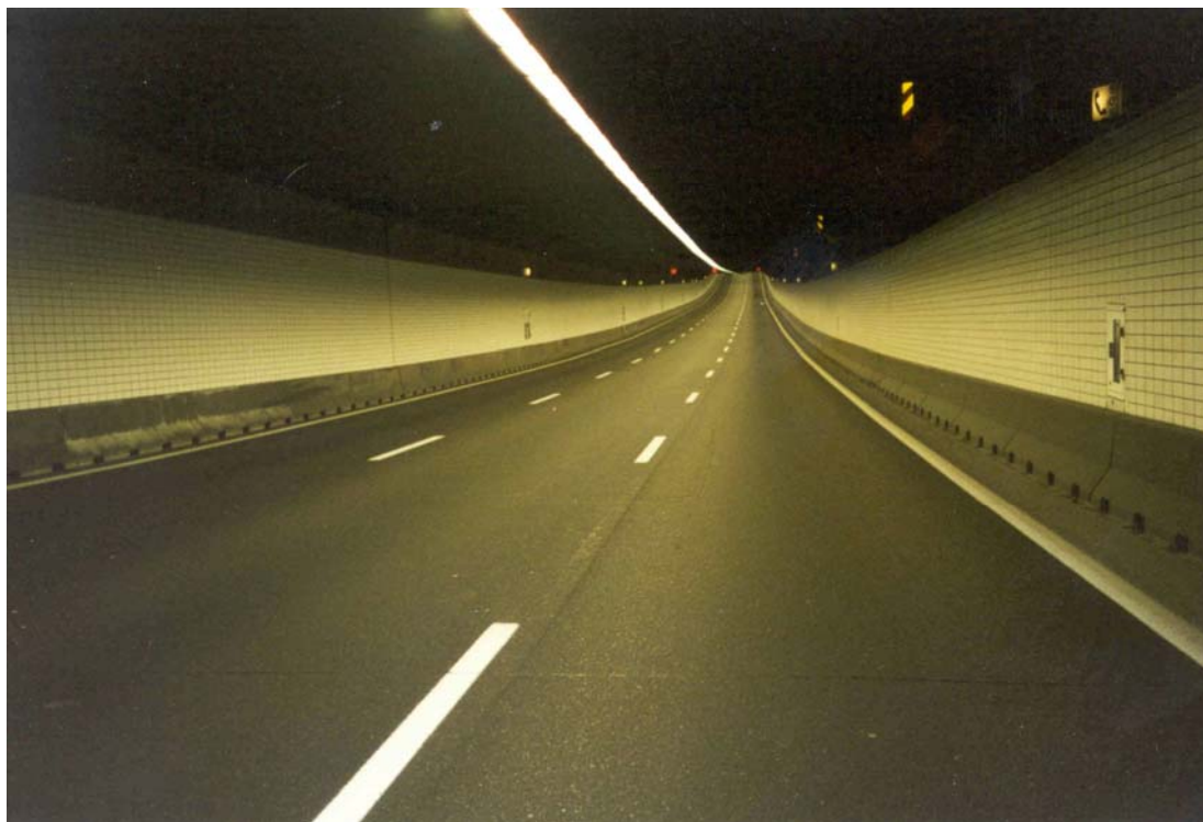
Fig. 1 Tunnel onder de Noord gezien vanaf de Westzijde, september 2001. Boven de hulpstukken witte bordjes; boven de vluchtdeuren groene bordjes. (De eerste vluchtdeur zit links, onder het derde bordje van links; de vluchtdeuren zijn vrijwel onzichtbaar.)
