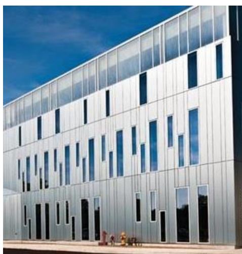
Een gevel met toepassing van verschillende maten gevelpanelen: een uitdaging voor BIPV
