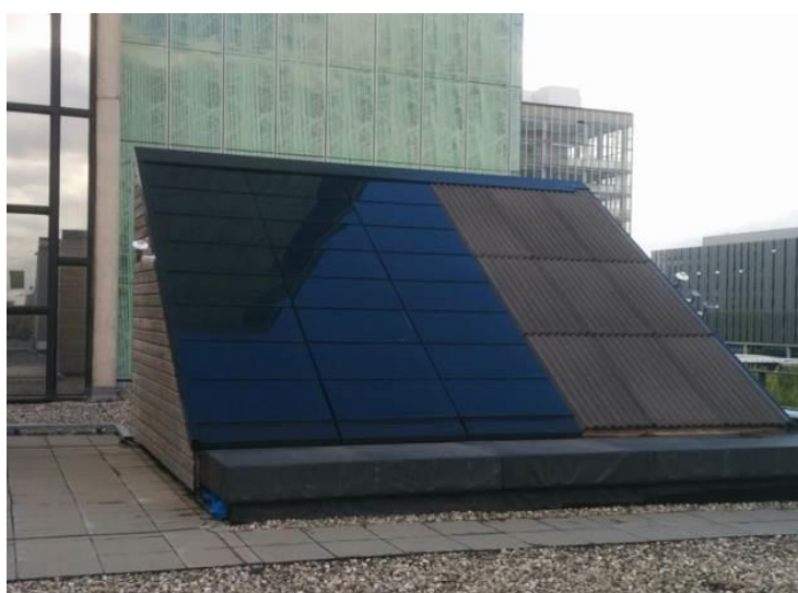
De Groene Combi opstelling. Onder de panelen zijn luchtkanalen en afzuiging aangebracht.
