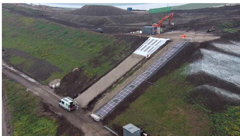
De laatste afsluitende installatiewerkzaamheden aan de PAS veldtest in oktober 2015.
