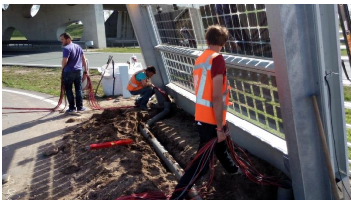
Installatiewerkzaamheden bij het SONOB geluidsscherm aan de Ringbaan West in 's-Hertogenbosch
