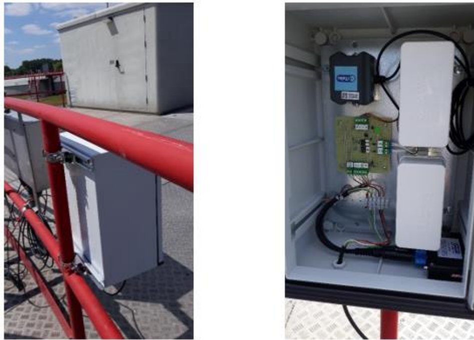
Figuur 19: Achterzijde en binnenkant Connection Box
