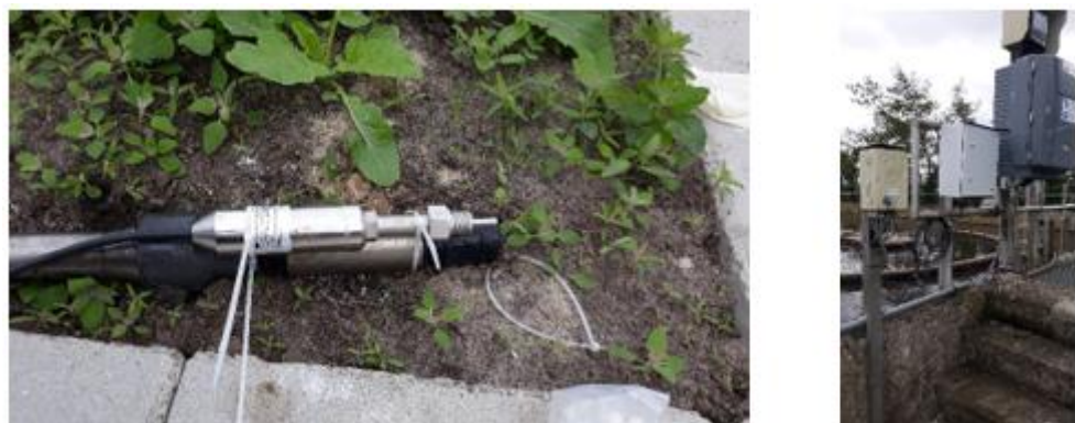
Figuur 21: Bevestiging temperatuursensor en locatie Connection Box
