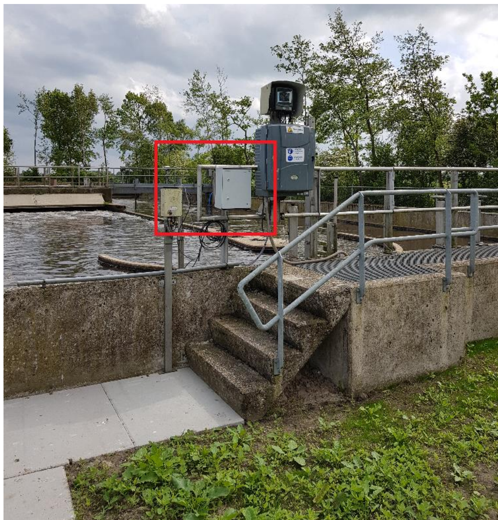
Figuur 23: De geplaatste Connection Box bij de beluchtingsbak
