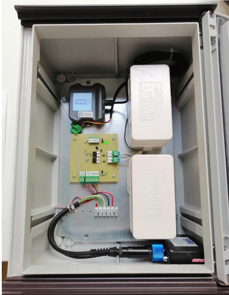
Figuur 10: Close-up van Connection Box
