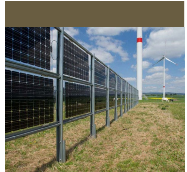
Meest voorkomende opstellingen Verticale opstelling met bi-faciale panelen
