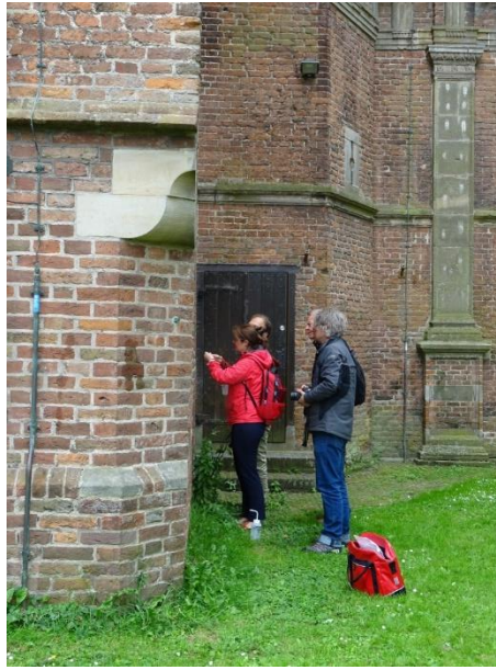
Fig. 7. Herinspectie van de in het verleden gehydrofobeerde St. Nicolaas in IJsselstein in juni 2018.
