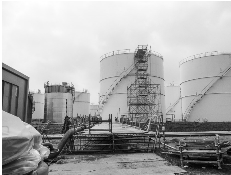
Meetlocatie 1C: Overzichtsfoto van omstandigheden tijdens afbreken steigermateriaal (5 weken na straalwerkzaamheden, vooraf is de tank schoongemaakt)
