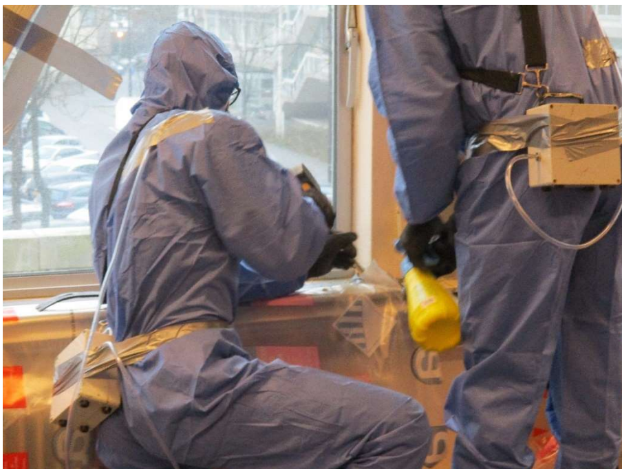
Toepassen emissiebeperkende maatregelen tijdens losbikken vensterbank
