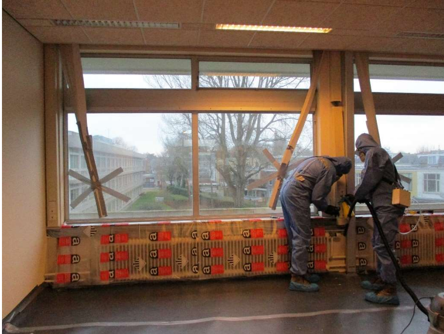
Toepassen emissiebeperkende maatregelen tijdens losbikken vensterbank
