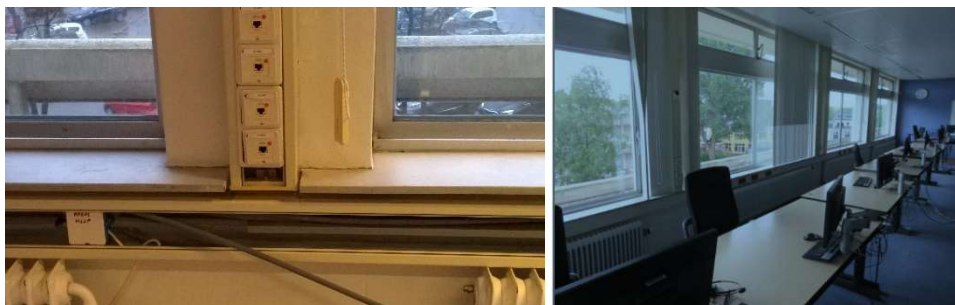
Figuur 1: Bevestiging vensterbanken Tesselshadestraat 4 te Leeuwarden
