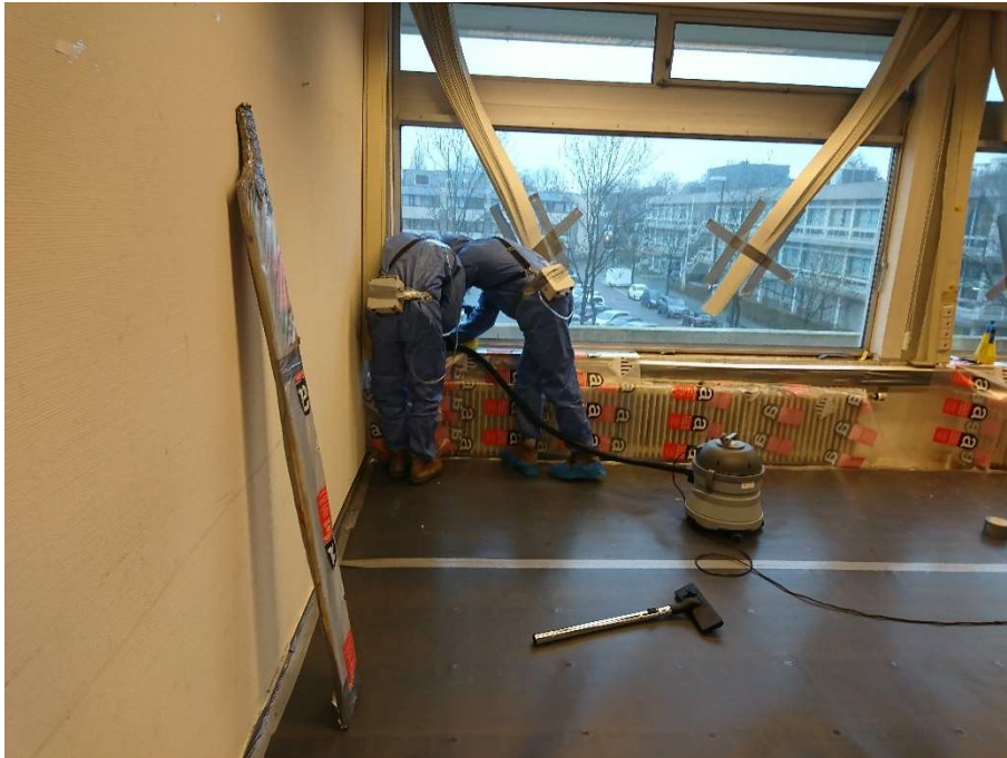
Verwijderen vensterbank aan zijkant ruimte 2
