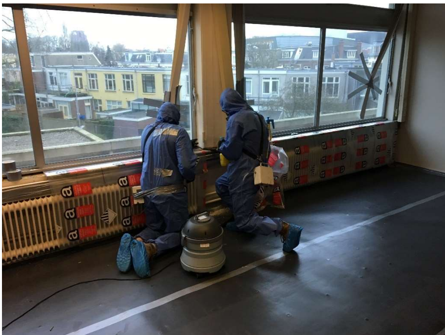
Toepassen emissiebeperkende maatregelen tijdens losbikken vensterbank
