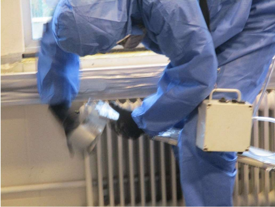
Inpakken vensterbank, intapen uiteinden vensterbank
