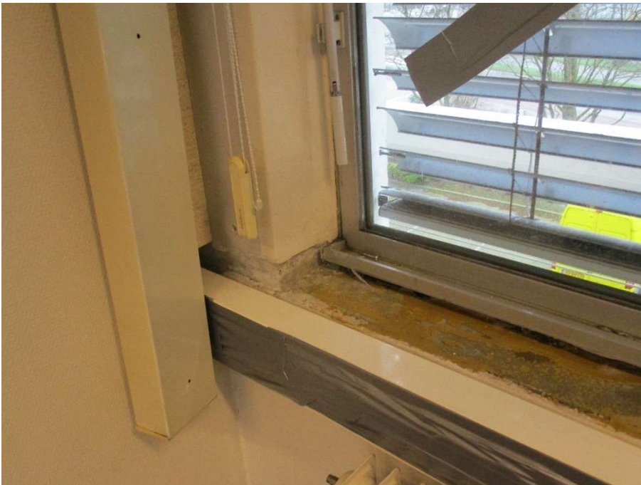
Na verwijderen vensterbank
