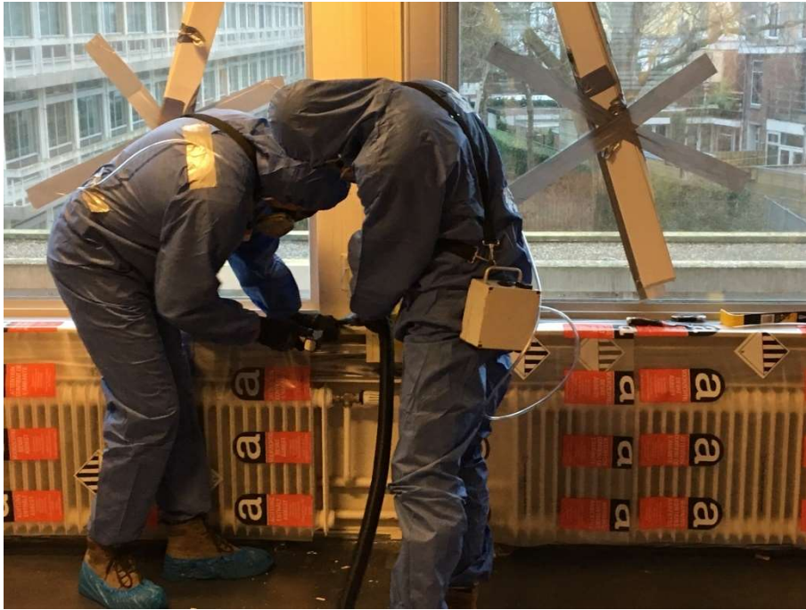
Begin maken met loswrikken vensterbank, aan de zijkant
