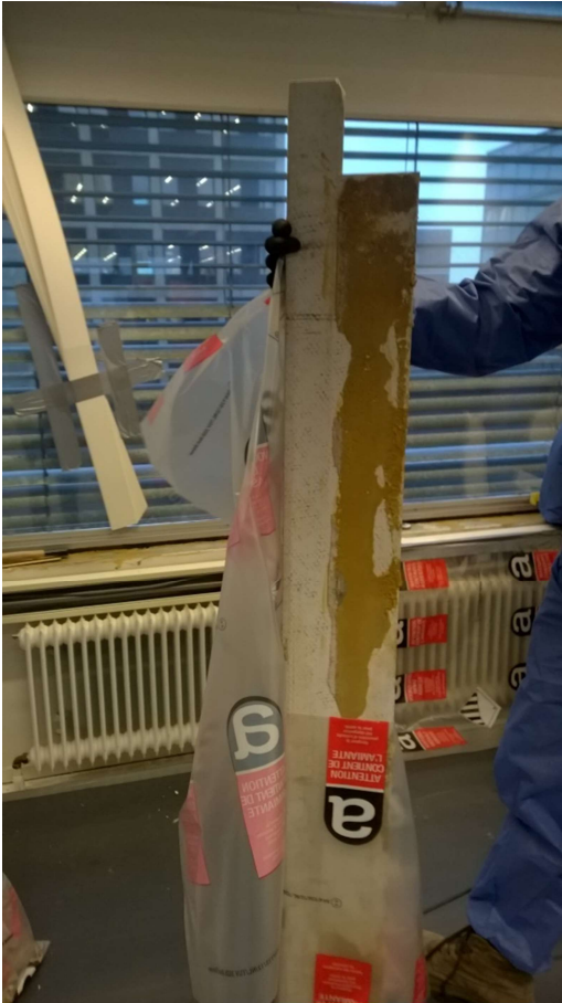
Onderkant van verwijderde vensterbank
