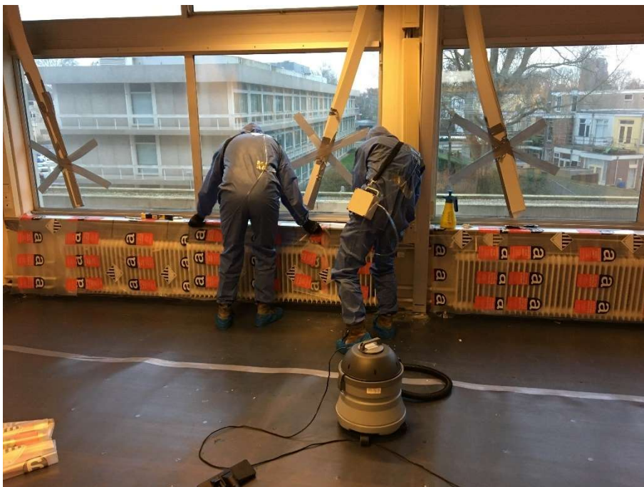
Gezamenlijk vensterbank naar voren trekken om deze in z'n geheel te kunnen verwijderen
