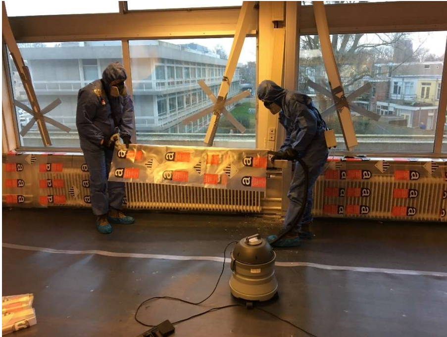
Samen vensterbank in plastic rollen nadat deze is losgemaakt
