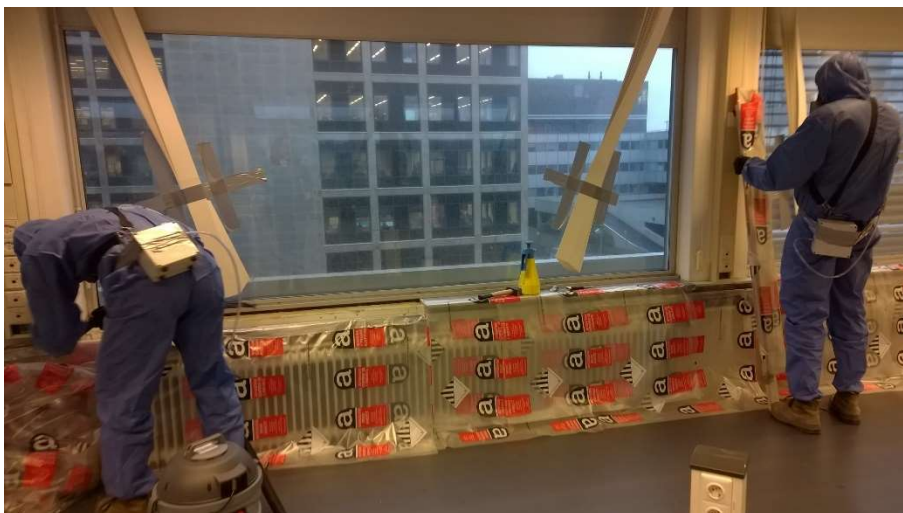
De ene saneerder gaat verder met inpakken terwijl de andere saneerder het werkgebied schoonmaakt
