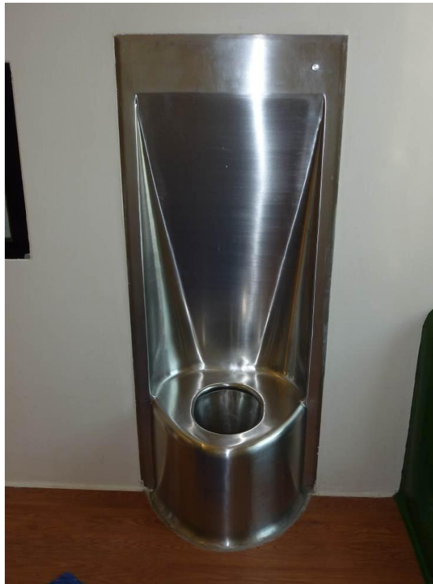
Figuur 29 Suïcide- en molestbestendig RVS toilet in separeerkamer (FPA Palier, (Parnassia), Den Haag).
