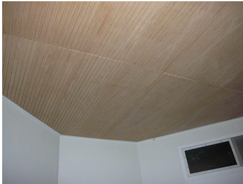
Figuur 13 Akoestisch sleuvenplafond in een afzonderingskamer (Amarant, Tilburg).
