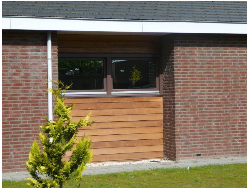
Figuur 8 Beperken inkijk in afzonderingskamer met spiegelende beglazing (Lunetzorg, Duizel).
