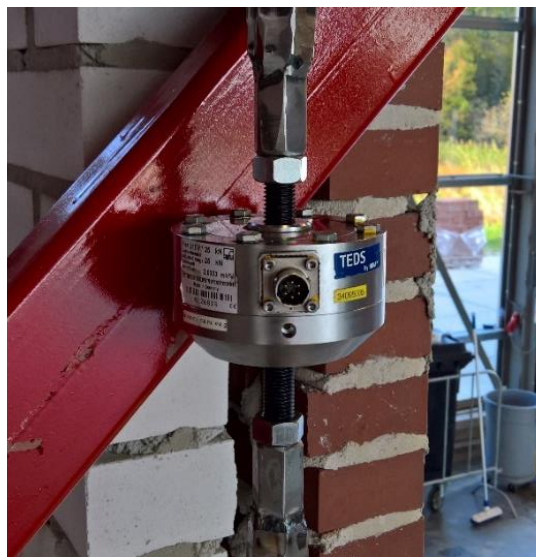
Figuur D.3 Detailfoto van een verticaal geplaatste krachtopnemer
