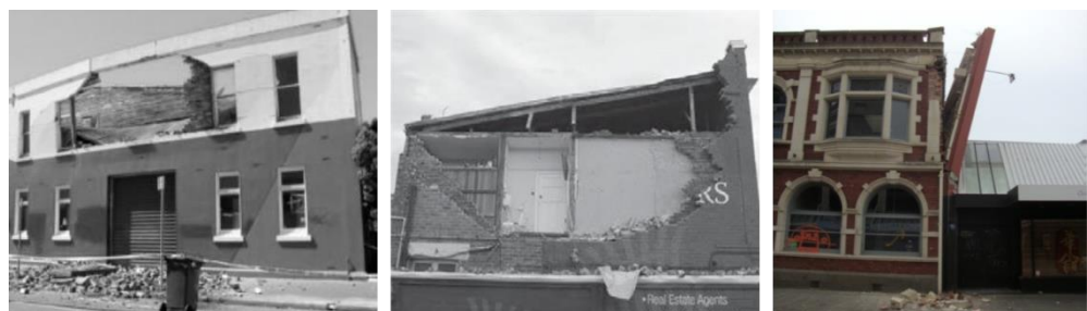
Figuur 2 Voorbeelden van uit-het-vlak schade aan metselwerk gebouwen, afkomstig uit Dizhur et al. [2].
