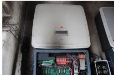
De kap van de linker omvormer verwijderd
