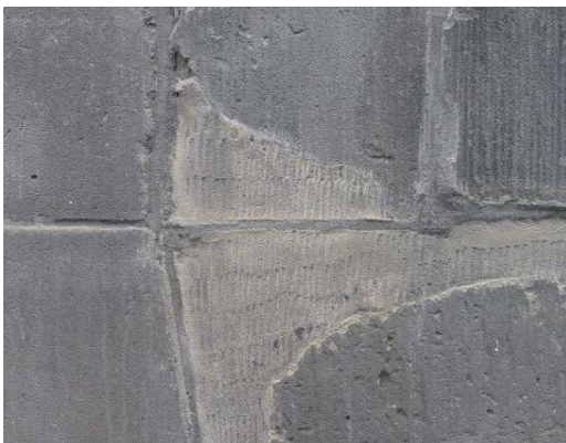
Figuur 25: Voorgevel van het Trippenhuys in Amsterdam, Bentheimer zandsteen met mortelreparaties (links) en inboeting met natuursteen met daarnaast een hoek die hersteld is met mortel (rechts).
