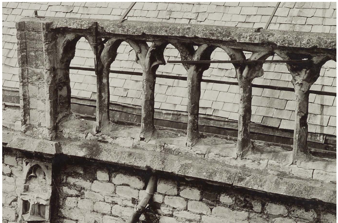
Figuur 1: Zwaar waterbelaste en/of zwaar gedegradeerde onderdelen werden in de negentiende eeuw regelmatig aangesmeerd met (cement)mortel, zoals uit oude onderhoudsbestekken en oude foto's blijkt. (foto: 1905, Rijksdienst voor het Cultureel Erfgoed OF-03057)
