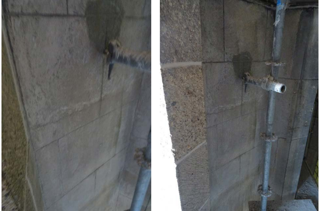
Figuur 5: Vlakvullende mortelreparaties van tufsteen aan de Domkerk in Utrecht, waarschijnlijk aangebracht tijdens de restauratie onder W.J. Kamperdijk vanaf 1850. 13
