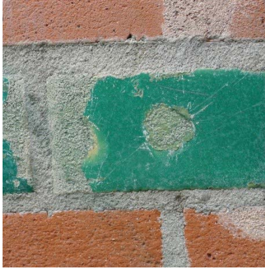
Figuur 27: Gevel aan de Raadhuisstraat-Keizersgracht met storende mortelreparaties van baksteen
