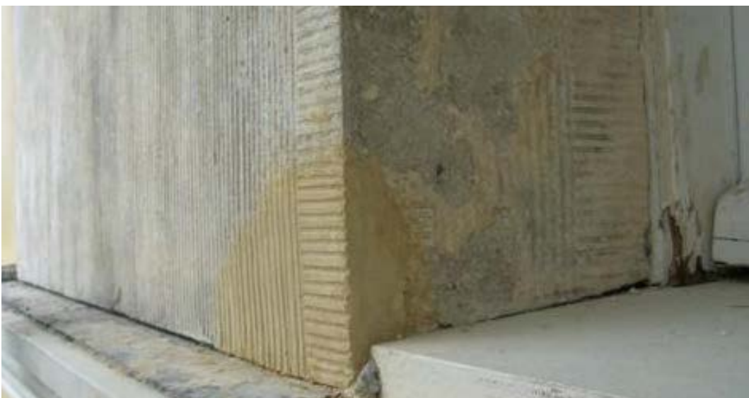
Figuur 64: Mortel voorzien van typische randslag voor zandsteen.
