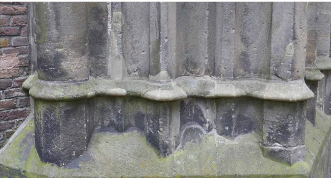
Figuur 29: Het dwarstransept van de Domkerk in Utrecht. Geveldeel en basement van rode zandsteen en hoekblokken van ledesteen, hersteld met reparatiemortel.
