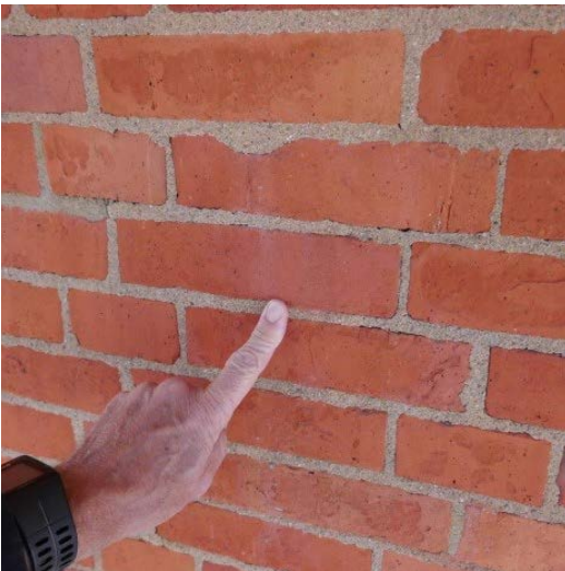
Figuur 28: Gevel van Het Schip in Amsterdam met nagenoeg onzichtbare reparaties van baksteen met Jahn-mortel, kort na uitvoering
