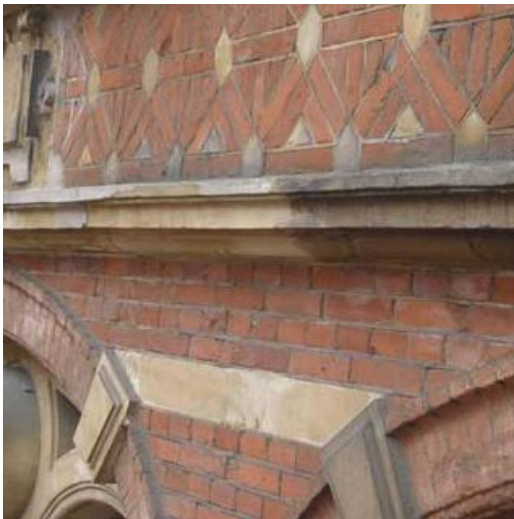
Figuur 30: Voorgevel in van een negentiende-eeuws winkel-woonhuis in Amsterdam. Natuurstenen waterlijst met oudere mortelreparties.
