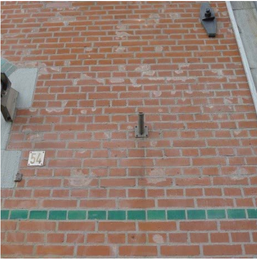
Figuur 27: Gevel aan de Raadhuisstraat-Keizersgracht met storende mortelreparaties van baksteen
