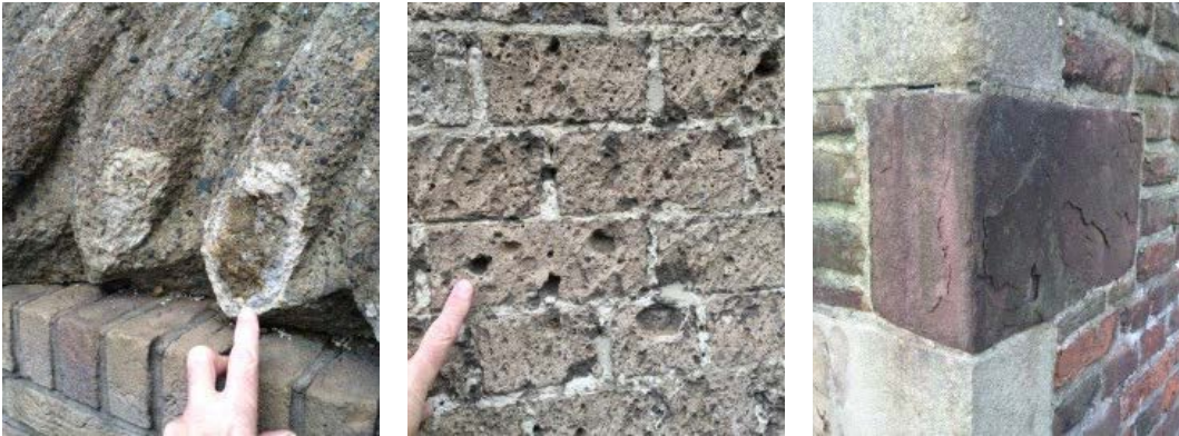
Figuur 63: Afgestoten hoek, selectieve vertering, laagvorming (exfoliatie)
