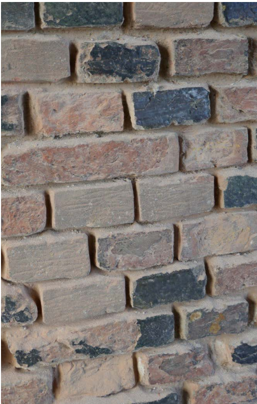
Figuur 22: Diverse oude reparaties aan de torenspits van de Oude Kerk in Delft. Jahnmortel op baksteen, circa 20 jaar oud (links) en Jahnmortel op tufsteen (rechts)
