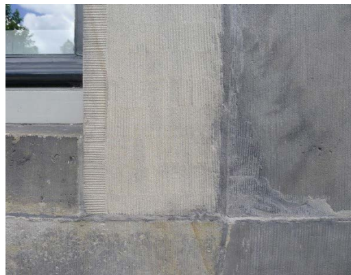
Figuur 25: Voorgevel van het Trippenhuys in Amsterdam, Bentheimer zandsteen met mortelreparaties (links) en inboeting met natuursteen met daarnaast een hoek die hersteld is met mortel (rechts).
