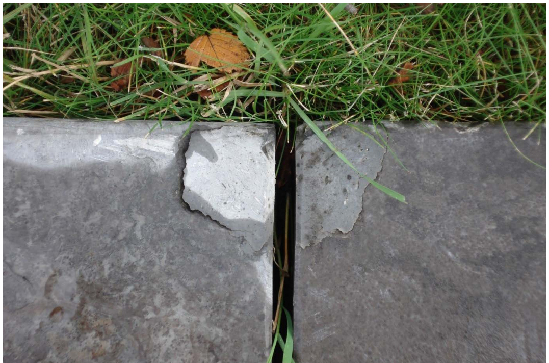
Figuur 10: Diverse stukken "Aziatische hardsteen" werden reeds gerepareerd geleverd voor en geplaatst in het Mekelpart te Delft. Overigens waren de reparaties van dusdanige aard dat de mortel binnen enkele jaren allemaal verdwenen is.
