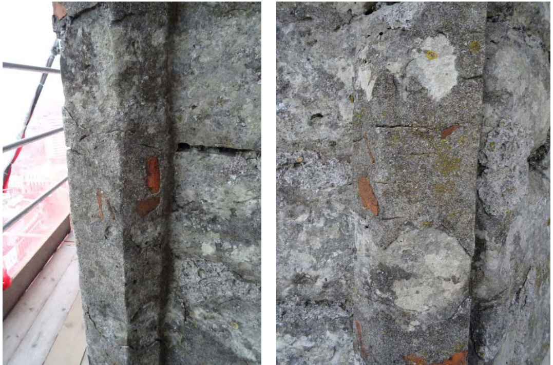
Figuur 6: Mortelreparaties op natuursteen aan de lantaarn van de Domtoren in Utrecht, waarschijnlijk aangebracht tijdens de restauratie onder leiding van F.J. Nieuwenhuis in de periode 1875-1920.
