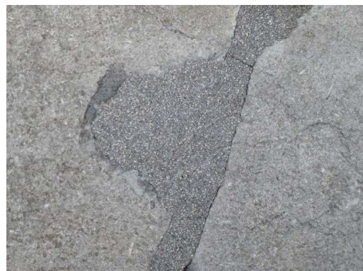
Figuur 26: Voorgevel van de Sint-Nicolaaskerk in Amsterdam met mortelreparaties. Gevel van Aschaffenburg zandsteen met reparaties met Monulit uit de periode 1994-1996 (boven) en plint van de R.K. Nicolaaskerk, hardsteen met Monulit reparaties (midden en onder)
