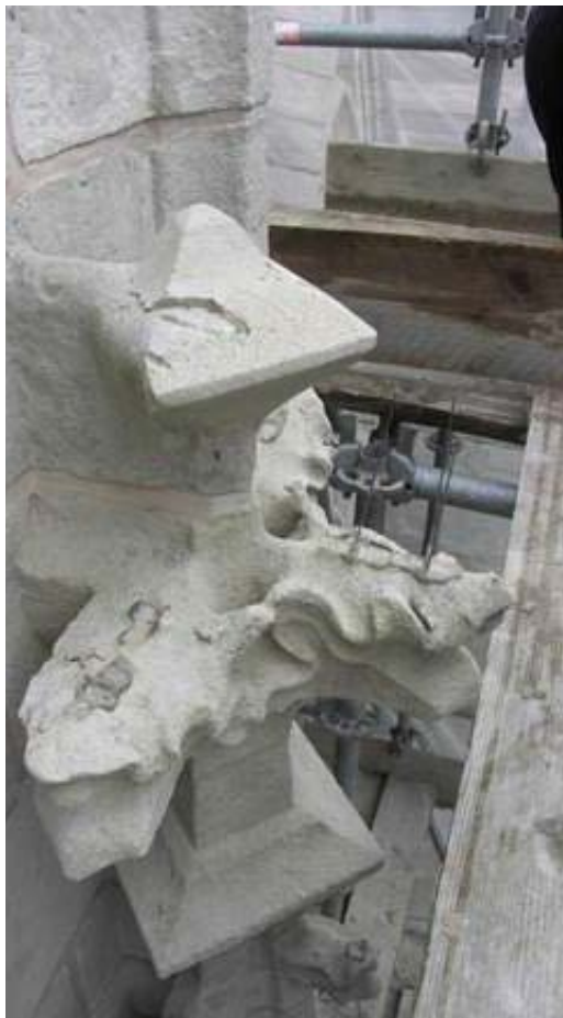
Figuur 32: Natuurstenen elementen met mortelreparaties van de grote kerk in Breda.
