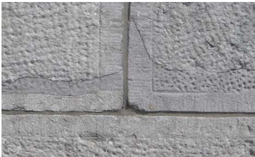
Figuur 23: Amsterdam, hoofdgebouw centraal station met diverse oudere mortelreparaties.
