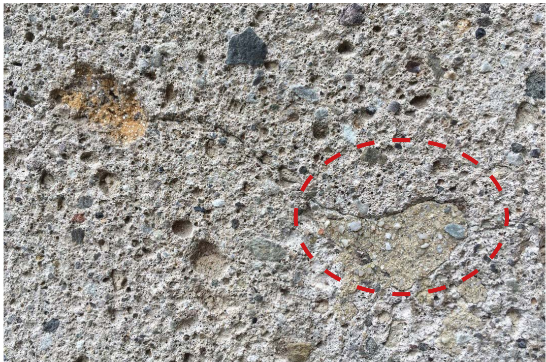
Figuur 8: Reparatie van Ettringer tufsteen aan de entree van BK-City. Onduidelijk is wanneer deze gaten zijn gevuld en waarmee.
