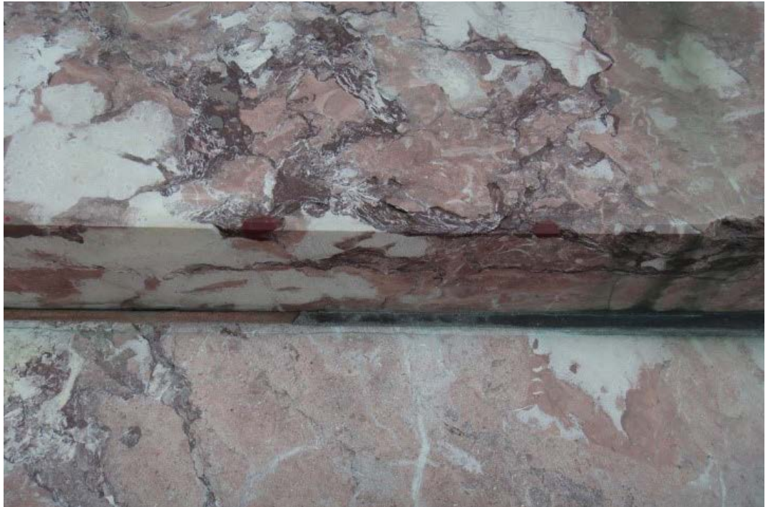
Figuur 9: Kunsthars met marmerfragmenten toegepast als herstelmortel van Belgisch rood marmer aan het monument Willem I in Den Haag.
