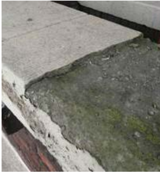
Figuur 31: Atlantic huis in Rotterdam, 'borstweringen' die over de volledige breedte zijn afgewerkt met mortel.
