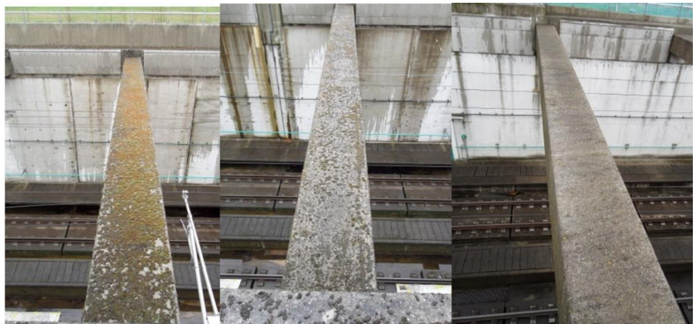
Figuur 5.2: Variatie in hoeveelheid mosgroei op bovenzijde stempels (foto B.2-B.4 in [02])
