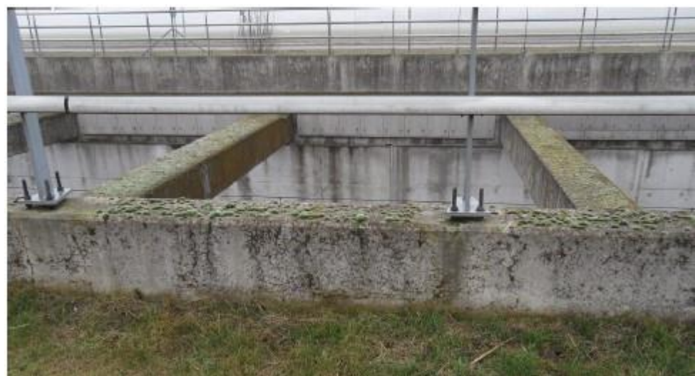
Figuur 5.8: Mosgroei op wandje op gording; geen mosgroei rondom staanders van hekwerk (foto B.7 in [02]).
