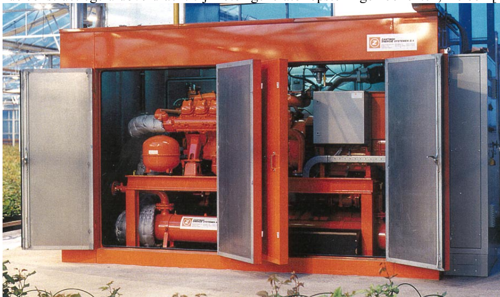
FIGUUR 1 165 kW in pandig geplaatste gasmotor-generator, voorzien van een omkasting.
