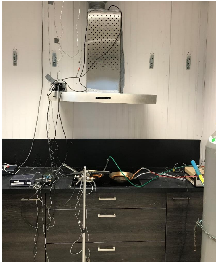
Figuur 27 Opstelling voor bepaling vangstefficiëntie. Op het statief vóór de linker pan is de CO 2 ruimtelucht sensor zichtbaar. Geheel boven is de CO 2 sensor zichtbaar van de toevoer lucht. De derde sensor (niet zichtbaar) bevindt zich in de afvoerlucht van de afzuigkap.
