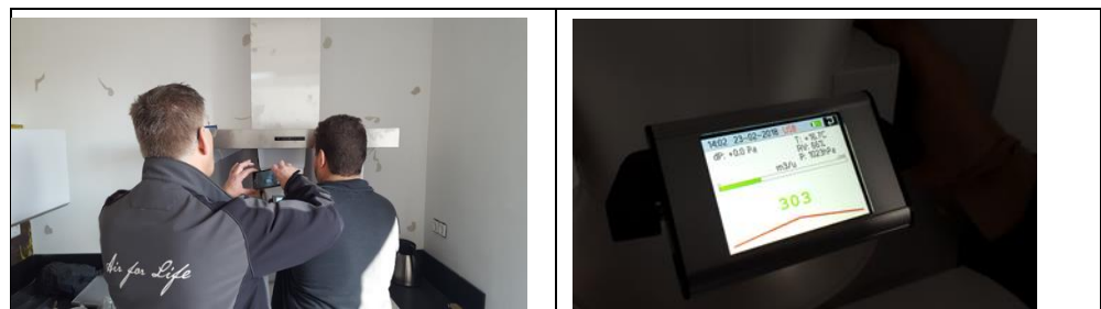
Figuur 14 meting afzuigdebiet motorloze afzuigkap op 23 februari 2018.
