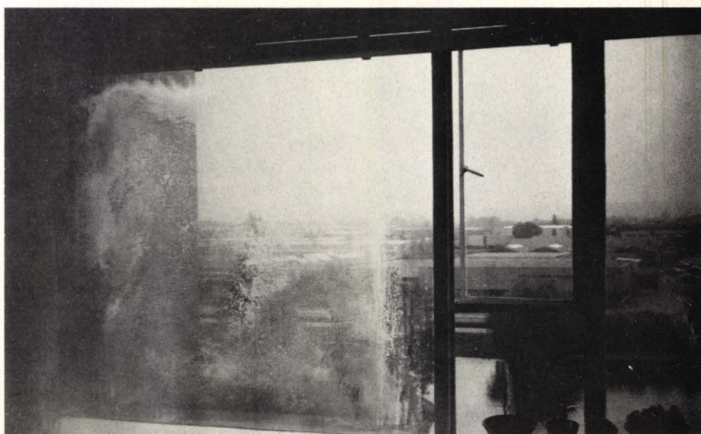
Fig. 3. Voorbeeld van een schadegeval waarbij niet alleen het doorzicht maar ook het uitzicht door de aantastingsvlekken nadelig wordt beïnvloed.
