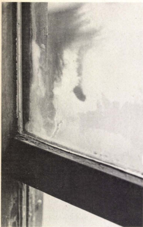
Fig. 2. Detail van een aangetaste dubbele ruit.
