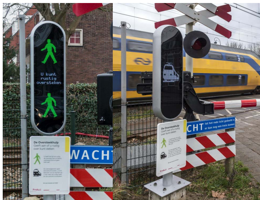
Figuur 4 Geplaatste Oversteekhulp Westergracht Haarlem.
