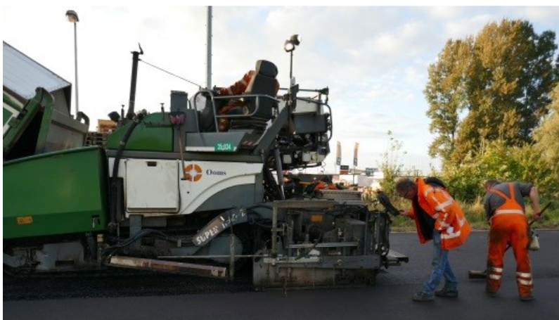
Figuur 2: Aanleg van het proefvak
