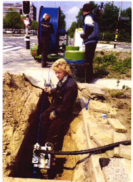
Fig. 4: Het blazen van glasvezel (fibre) in een buitenbuis (duct)
