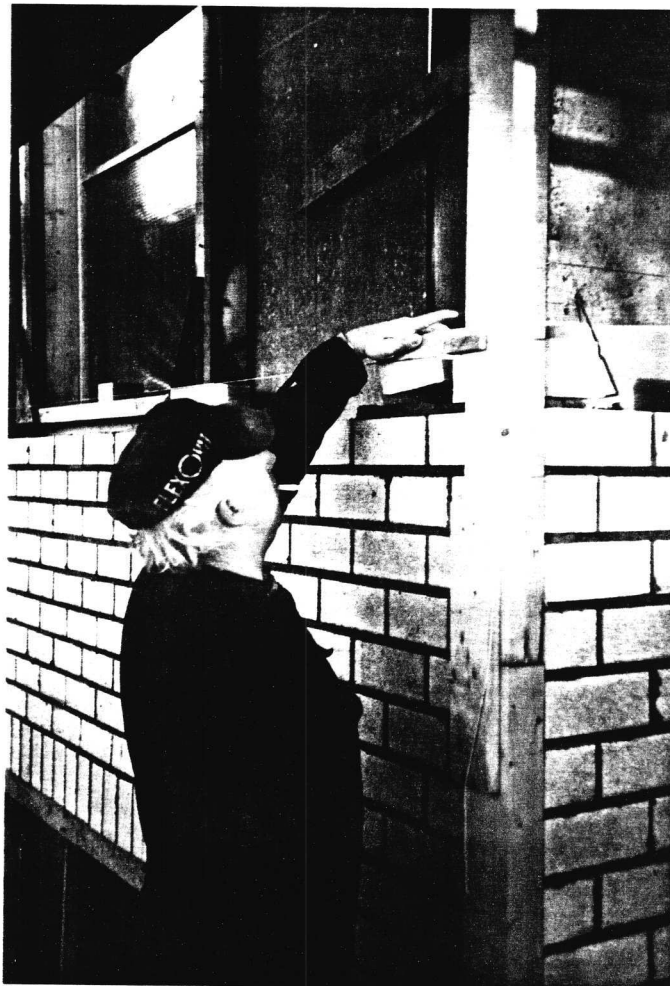
SCHOON METSELWERK MET WITTE BETONSTEEN
