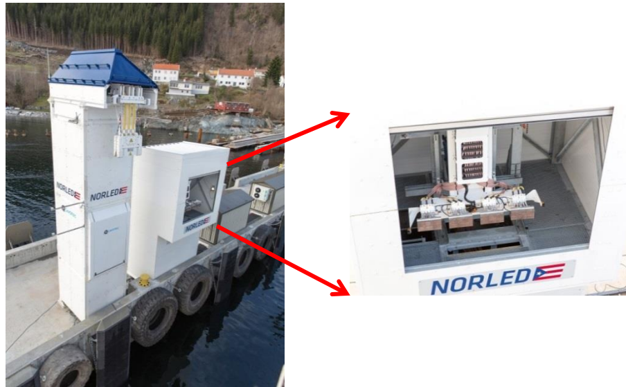
Figuur 16: De laadverbinding van de Norled-veerboot. De laadaansluiting op de steiger is ongeveer zo groot als een krantenkiosk. Om het lokale elektriciteitsnet te ontzien zijn op beide oevers accu-buffers van 260 kWh capaciteit geïnstalleerd. Op de uitvergroting rechts zijn de aansluitcontacten te zien.
