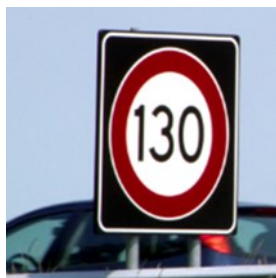
Figuur 10 Verkeersbord met achtergrondschild en een witte bias. Foto: RWS.
