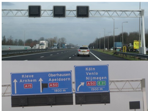
Figuur 4 Verkeerssignalering in 2 uitvoeringen: solitair met achtergrondschild en witte ligger (boven) en onder bewegwijzering (onder). Foto's: RWS.
