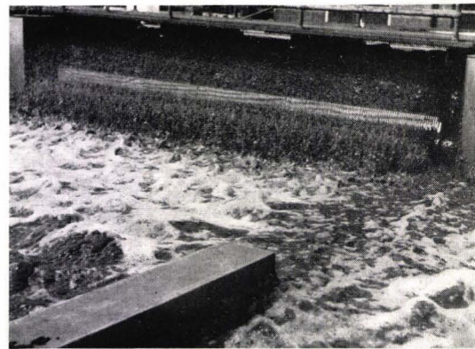
Bild 3. Eine Bürstenwalze in bisheriger Ausführung.
