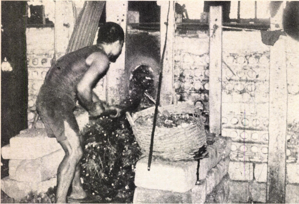
Figuur 1. Kleinschalige glasfabricage met primitieve middelen – het toevoegen van scherven aan de smeltoven
