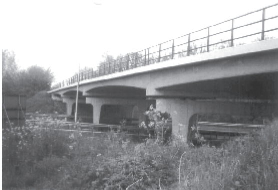
Fig. 2. Overview of viaduct Vlijmen-Oost.
