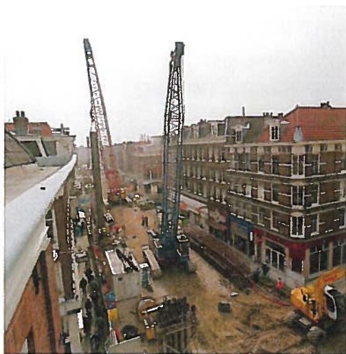
Uitzicht op de bouwput
