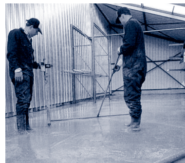
Voorbeeld van een innovatie met succesvolle invoering; de zelf egaliserende vloei vloer. De vloei vloer wordt naar het werk gepompt. De werknemer rechts verricht de laatste afwerking.
