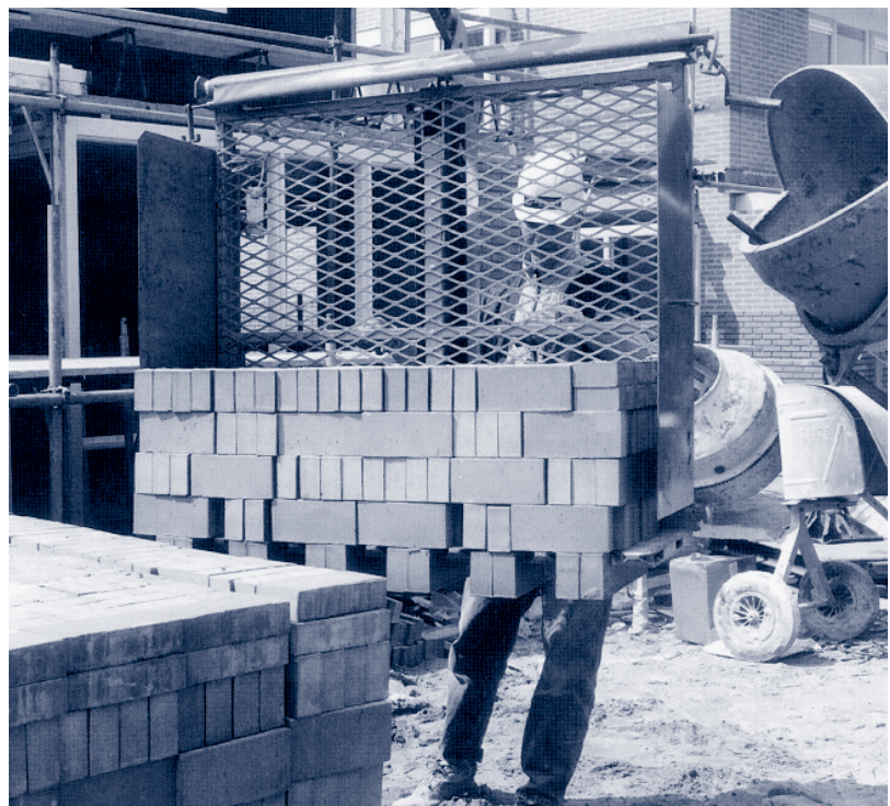
Voorbeeld van een innovatie met succesvolle invoering; de 6-voetstang voor de opperman voor mechanisch transport van bakstenen. Deze tang is te gebruiken met een kraan of een verreiker waarmee happen van 200 bakstenen op de metselplek worden geplaatst.
