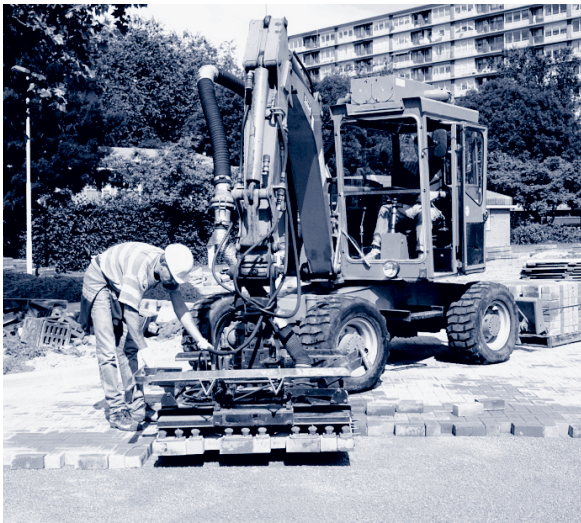
Voorbeeld van een innovatie met 'beperkte invoering'; een bestratings-machine voor de stratenmaker. De machine pakt pakketten stenen of banden en plaatst ze machinaal in verband. (Foto: D. Vader)
