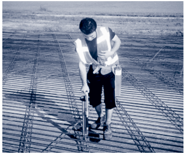
Voorbeeld van een innovatie met 'beperkte invoering'; de Drillfix voor de betonstaalvloer. De Drillfix wikkelt de draad automatisch om de kruising van de staaldraden. (Foto: P. Bos)
