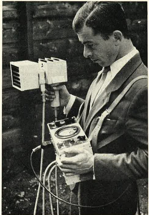
Afb. 5. Electriche apparatuur voor het verrichten van vergelijkende stofmetingen , draagbare uitvoering voor metingen in fabrieken.
